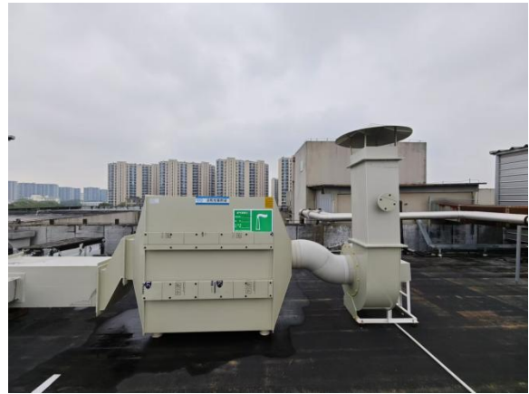
废气排放口标牌 (DA003)
